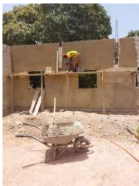
De muren worden afgesmeerd.
