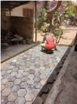
Grond nivelleren. Plavuizen leggen, Met een mengsel van zand en cement inwassen. 1 e gekleurde tegels.
