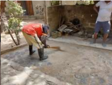
Grond nivelleren. Plavuizen leggen, Met een mengsel van zand en cement inwassen. 1 e gekleurde tegels.
