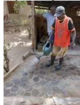
Grond nivelleren. Plavuizen leggen, Met een mengsel van zand en cement inwassen. 1 e gekleurde tegels.
